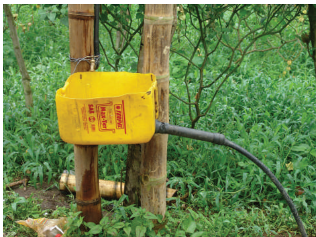
Figura 21. Lavamos sencillo, instalado en un cultivo de uchuva.
