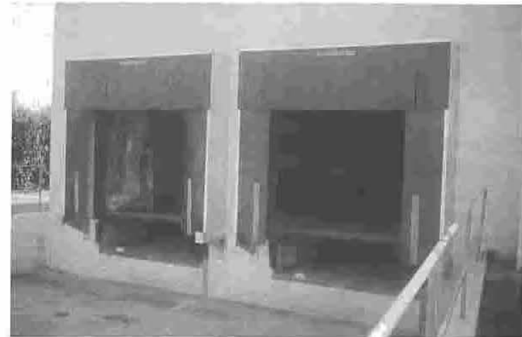
Cámara para el almacenamiento refrigerado
