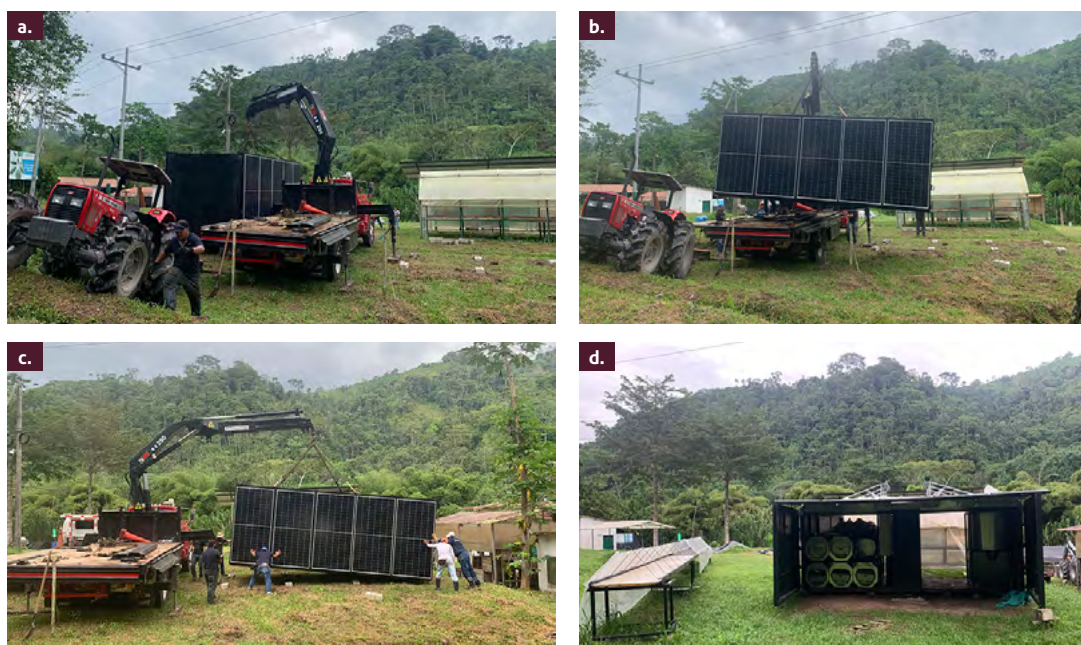
Figura 16. Planta Multipropósito para el Procesamiento de Cacao. a. Transporte; b y c. Instalación; d. Armado de la estructura modular.
