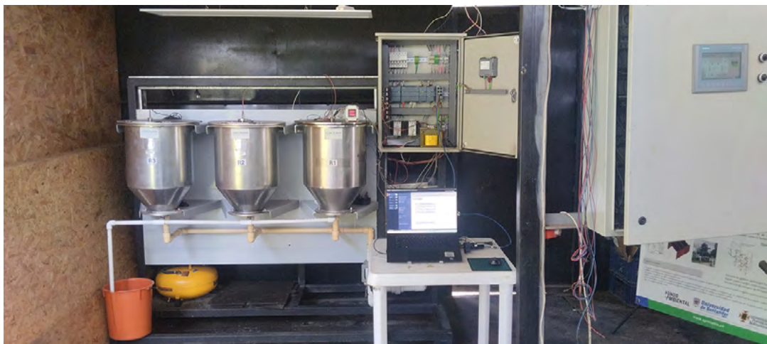
Figura 13. Sistema de microfermentación dirigida (controlada) acoplado al sistema SCADA.
