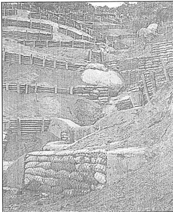
Foto 7 Obras típicas para el control de erosión
