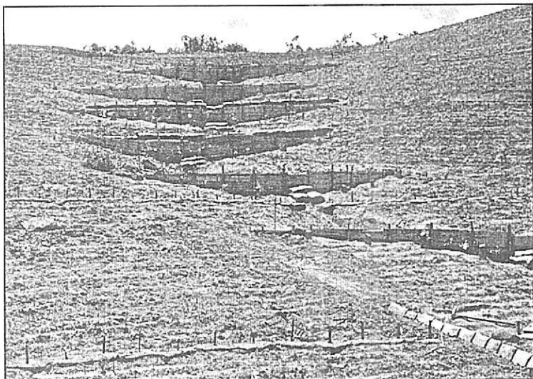
Foto 8 Trinchos y cunetas para recuperación del suelo
