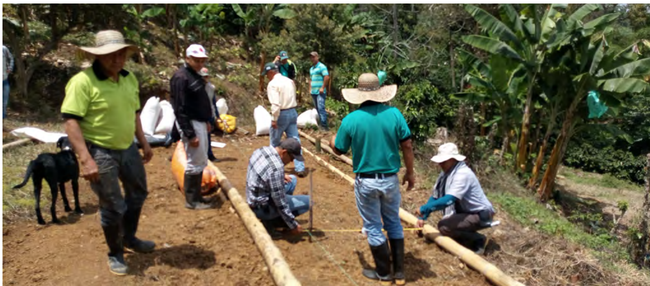
Figura 11 Inicio construcción base del túnel. Foto: Diana Milena Rodríguez Mora.
