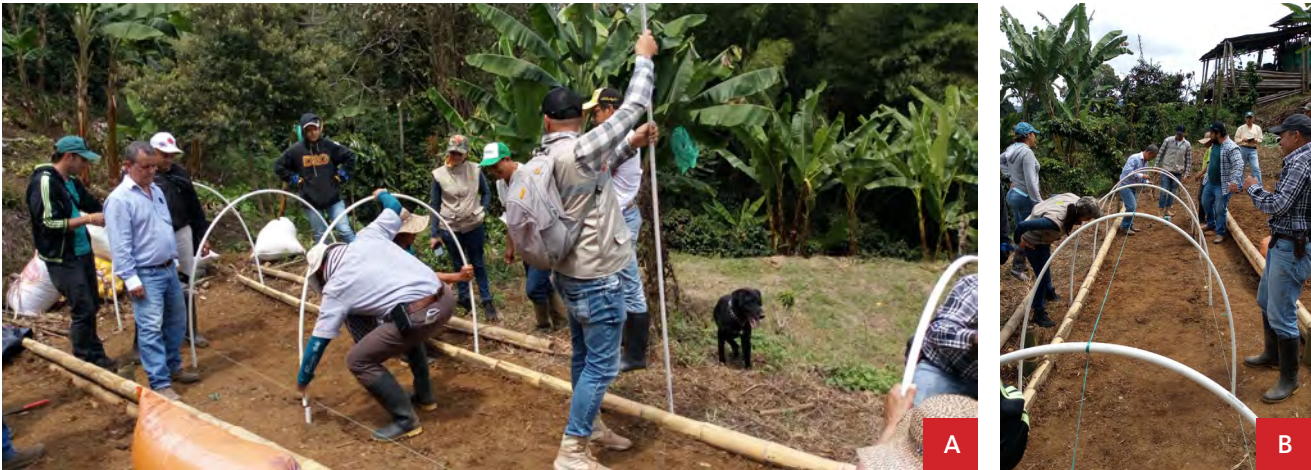
Figura 12. Forma de colocar los tubos de \frac{3}{4} de PVC para estructura del túnel. Foto: Diana Milena Rodríguez Mora.
