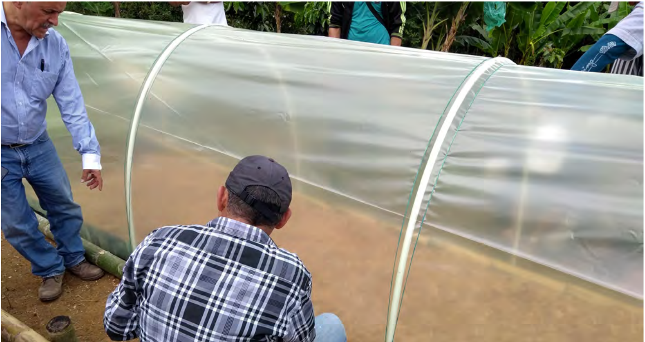
Figura 16. Detalles de amarre para estabilidad del túnel. Foto: Diana Milena Rodríguez Mora.
