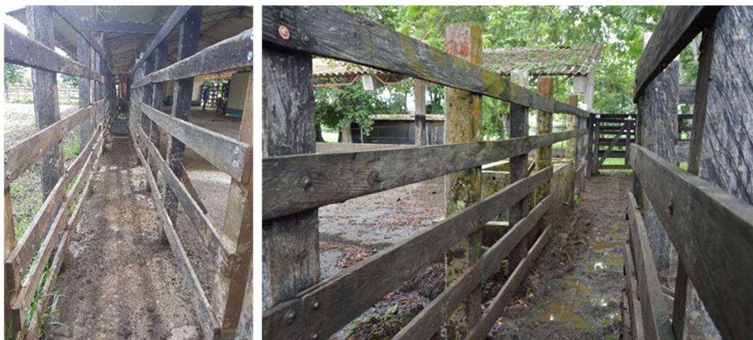
Figura 21. Manga de manejo animal abierta, con listones discontinuos que permiten la formación de luces y sombras
