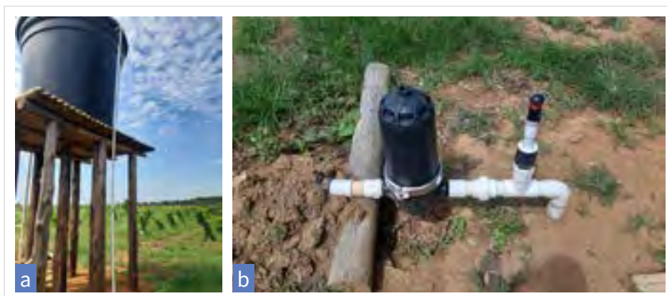
Figura 17. Monitoreo del suministro de agua para el cultivo. a. Seguimiento de la cantidad de agua almacenada; b. Filtro para asegurar el funcionamiento del sistema de riego.
