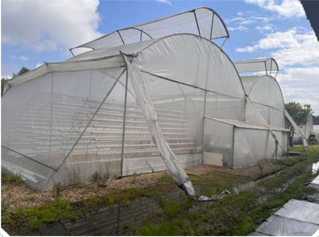
Figura 50. Estructura de invernadero usado para producción vertical.
