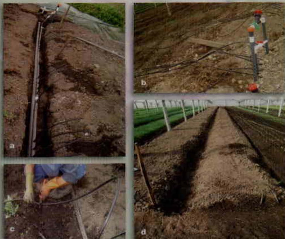
Figura 5. Ensamble de sistema de riego del cultivo cebollín A. schoenoprasum en la sabana de Bogotá: a. zanja con tubería principal del sistema de riego; b. instalación mangueras de goteo; c. corte de manguera de goteo y d. arreglo de camas
