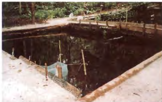
Estanques en tierra
