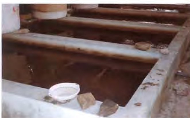
Piletas en concreto
