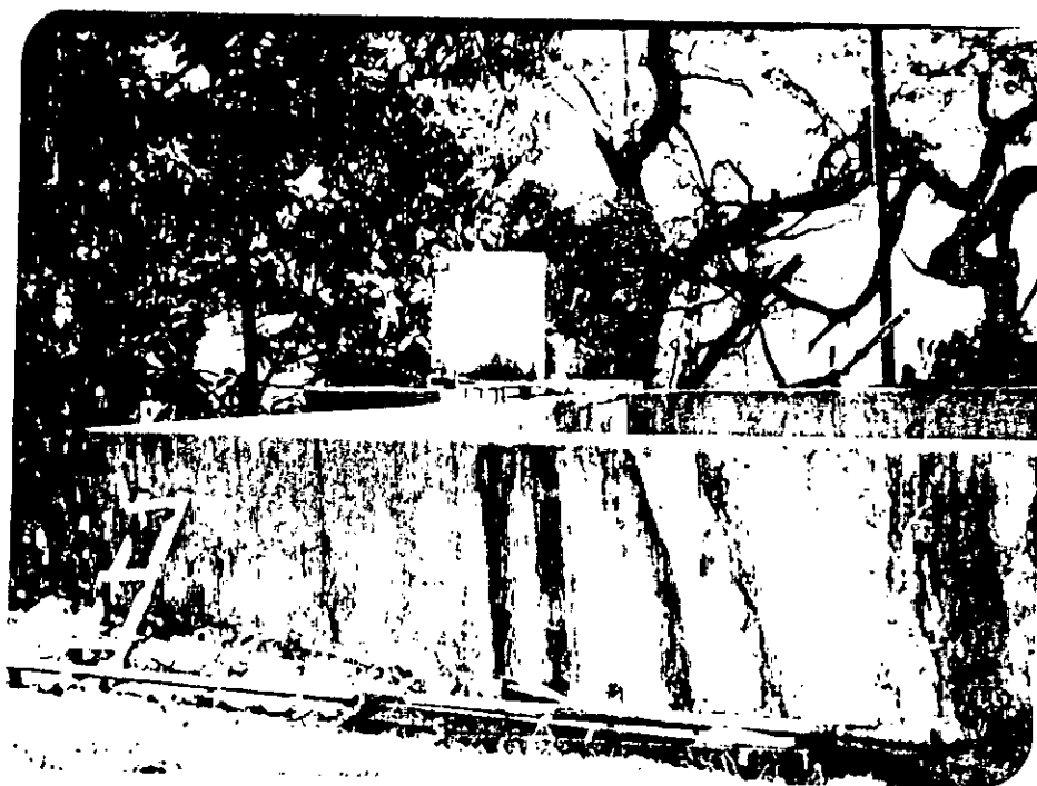
SISTEMAS ANTITECNICOS DE TRATAMIENTO DE AGUAS
