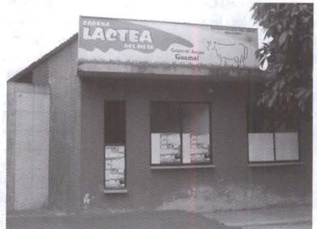
Centro de acopio de Guamal
