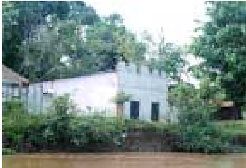
Dstrucción de orillas en el dique natural del río Sinú en el caserío de Nariño, Córdoba. Fotografía de Kim Robertson.
