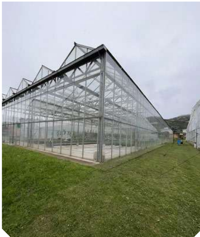
Figura 20. Invernadero tipo venlo con cubierta de vidrio.
