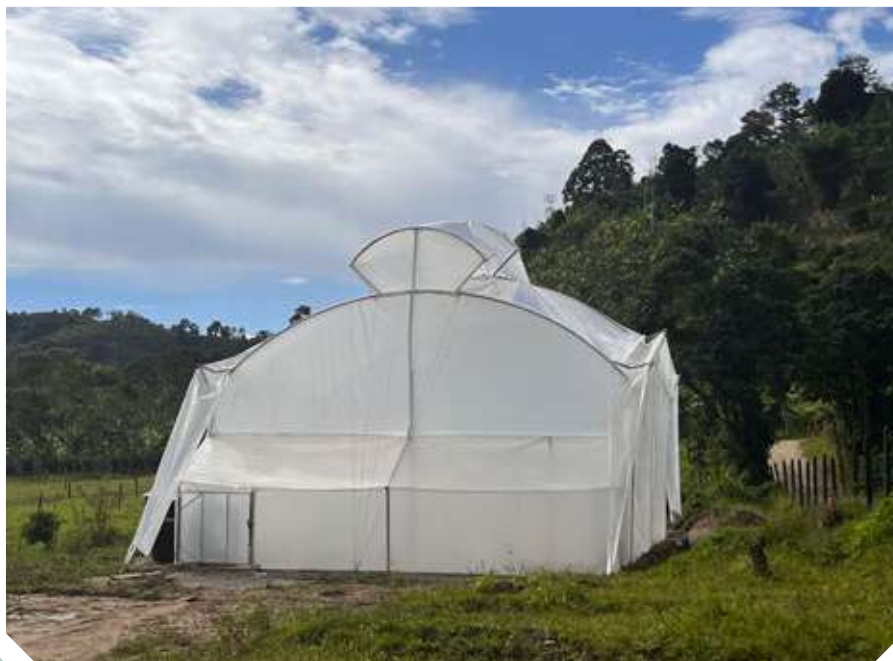
Figura 21. Invernadero tipo túnel monotramo con cubierta plástica.
