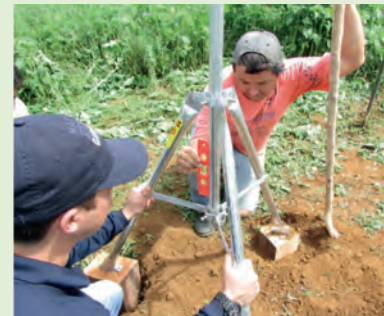
Figura 3. Instalación del trípode usando madera. Fuente: El Autor(a), Villa Nueva, Santander.
