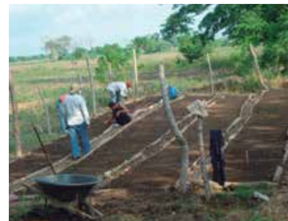
Figura 11. Construcción del vivero.
