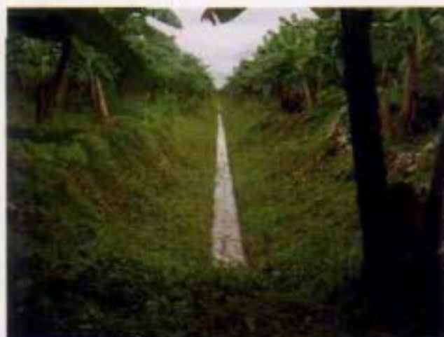
Foto 17: Mantenimiento de drenajes
