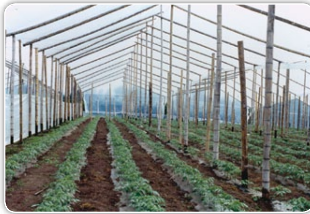
Figura 1.17. Invernadero construido con guadua
