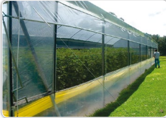
Figura 1.22. Ventanas para ventilación
